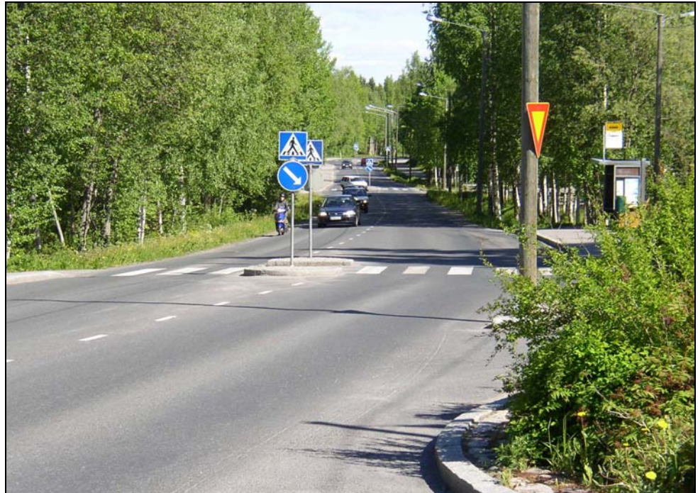
Kuva 5-6. Puijonsarventien suojaiteita esitetään korostettavaksi liikenteen jakajan merkkien jalkaan sijoitettavin heijastimin.
