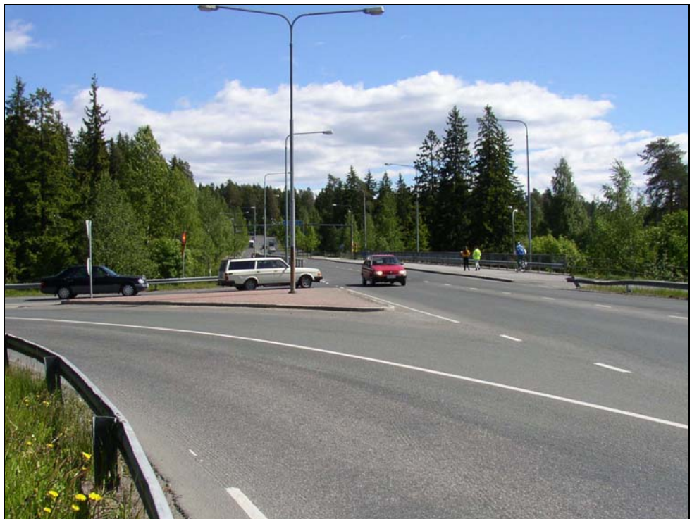
Kuva 5-2. Kellolahden eritasoliittymän pohjoisesta tulevan rampin näkemä Kelloniemen suuntaan on huono johtuen sillan kaiteesta.
