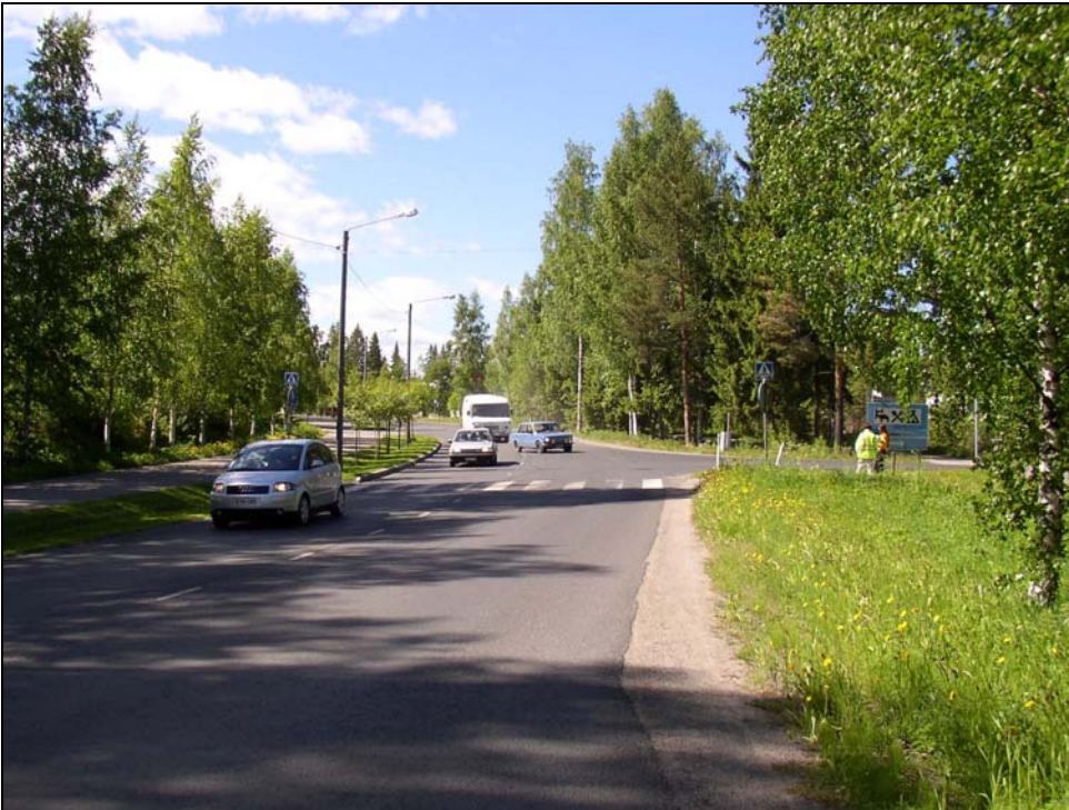
Kuva 5-3. Rauhalahdentien ja Kartanonkadun liittymässä on tapahtunut paljon onnettomuuksia. Liittymän suojateille esitetään keskisaarekkeiden rakentamista.
